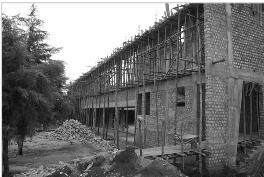
Abb. 2: Veranstaltungsgebäude für eine Schule, Uganda
