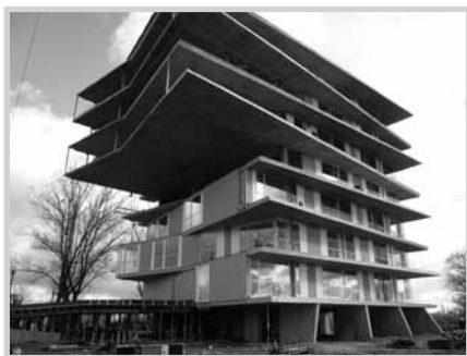
Abb. 5: Apartment Building Tartu / Estland Auskragung Objekt „Tower“
