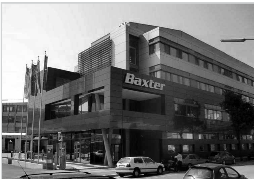
Abb. 1: BAXTER - Lange Allee 24 Wien, 1. Endzertifikat für LEED® in Gold in Österreich (zertifiziert durch die Dr. Pfeiler GmbH)
