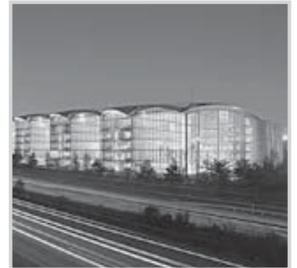
Abb. 16: Hauptverwaltung der Lufthansa AG (Ingenhoven Architekten)
