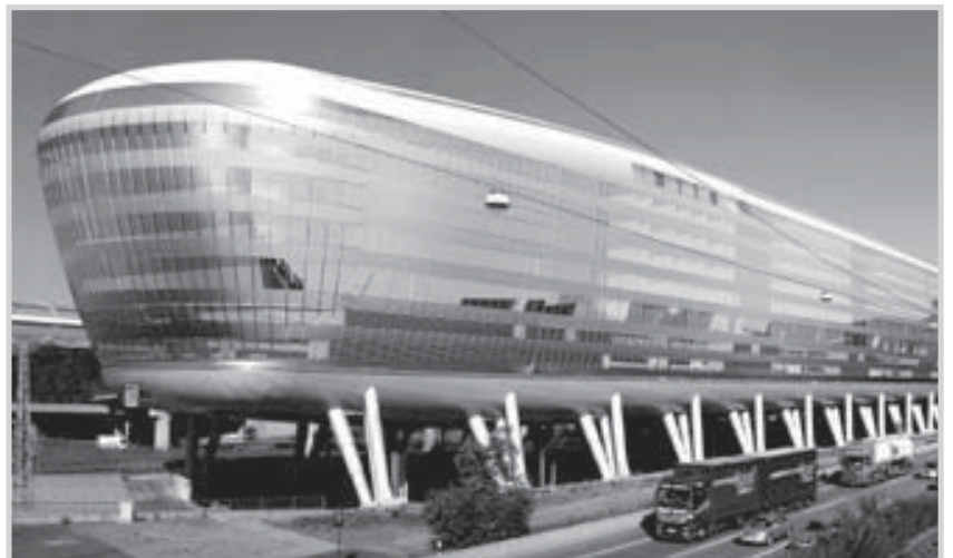
Abb. 17: AirRail Center (J.S.K. Architekten, im Bau seit 2007)
