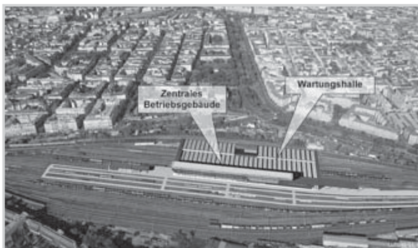
Abb. 11: Technische Betriebsanlagen Matzleinsdorf
