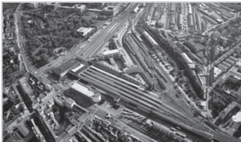
Abb. 1: Übersicht Süd-, Ostbahnhof, Frachtenbahnhof Wien Süd
