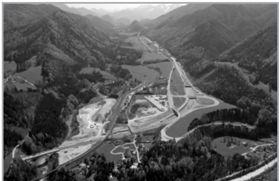
Abb. 3: A 9, Pyhrn Autobahn –Tunnelkette Klaus im Bereich St. Pankraz
