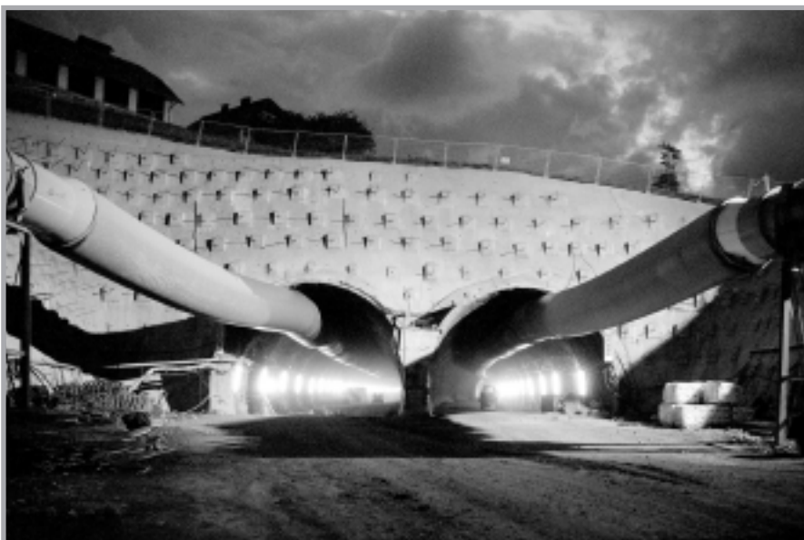
Abb. 4: S 6, Semmering Schnellstraße – Portalphoto Tunnel Steinhaus
