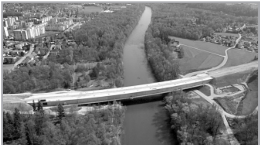
Abb. 1: Eingehauste Traunbrücke im Zuge der A 8, Innkreis Autobahn, Welser Westspange
