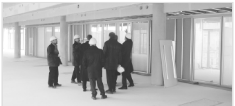
Abb. 6: Begutachtung einer Musterbürowand
